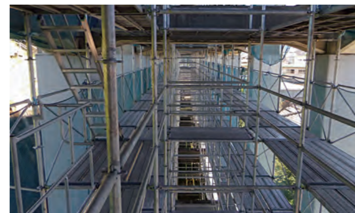
新幹線高架下の点検用通路 横断方向の中間梁があっても回避して設置可能 手すり付きの昇降階段・左右間の渡り通路も自在に設置
