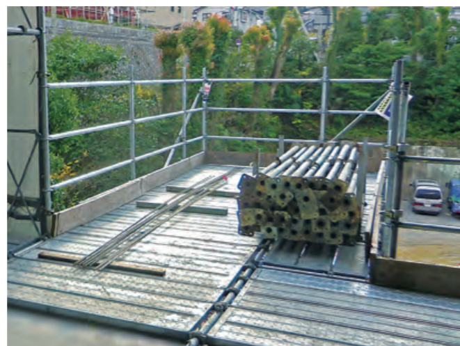
梁枠併用で広い開口確保
