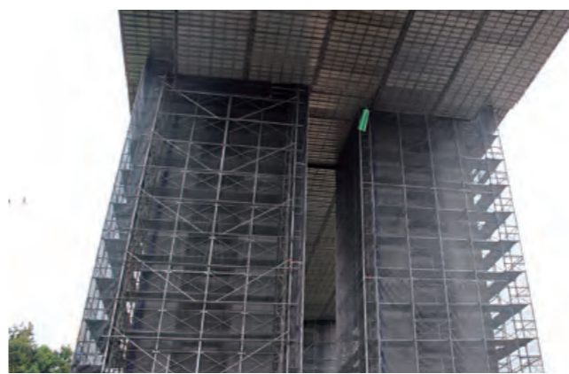
高速道路橋脚 上部工のつりだ足場SKパネルと組み合わせて設置
